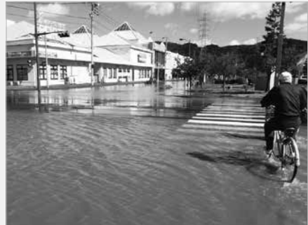
▲冠水した小島地区
