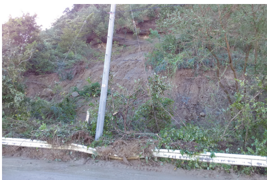
▲上大谷の土砂崩れ (10/13 (日) 午前9:00)
