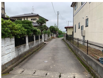
狭隘道路 (川西地区)
