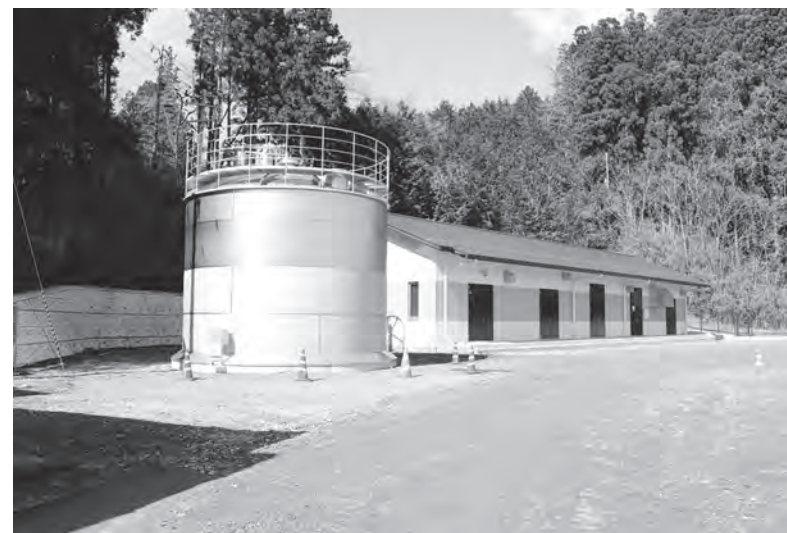
“おいしい水”を供給する金ヶ瀬場配水場
