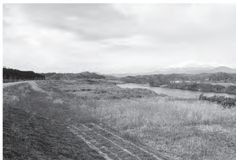
整備予定の白石川右岸河川敷
