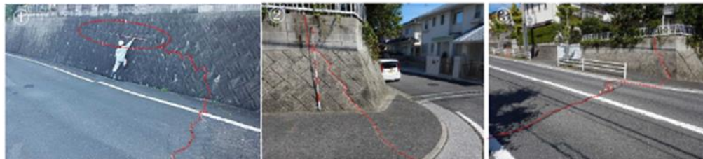
①擁壁から路面に至る連続したクラック
