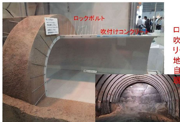
山岳工法(NATM工法)の断面模型と実際の掘削現場
