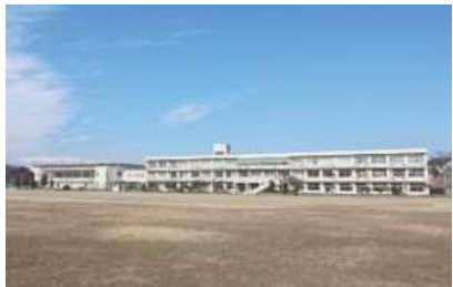
改修に着手する大河原南小学校
