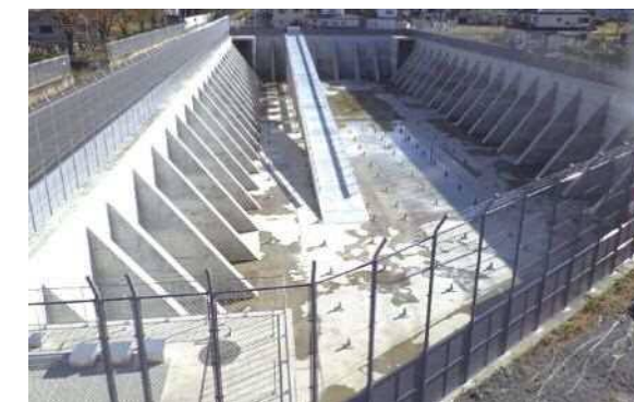
▲雨水調整池全景
