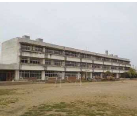
改修に着手する金ケ瀬小学校
