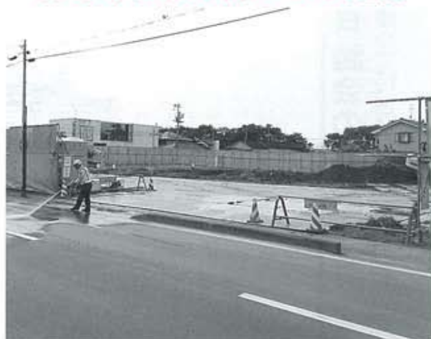
▲世代交流プラザ建設工事
