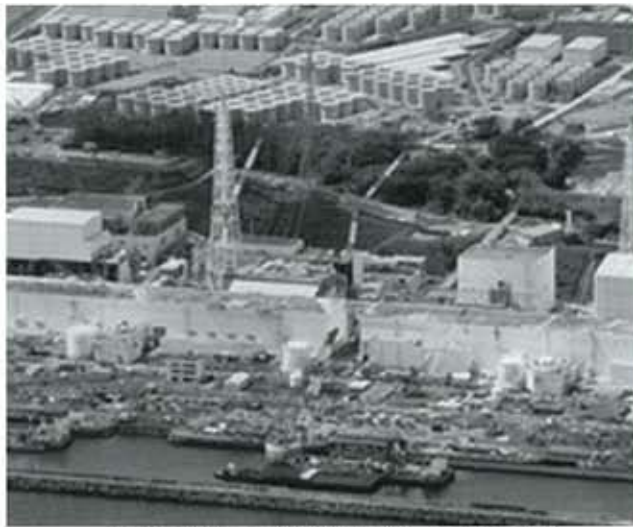
▲汚染水タンクが並ぶ福島第一原子力発電所
