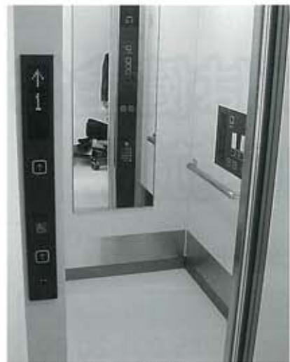
▲金小バリアフリー対策(エレベーター設置)
