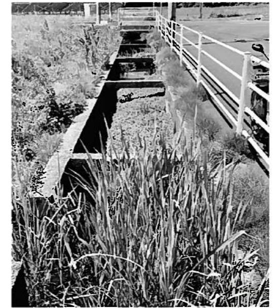
排水路の泥をかき内水氾濫を防げ
