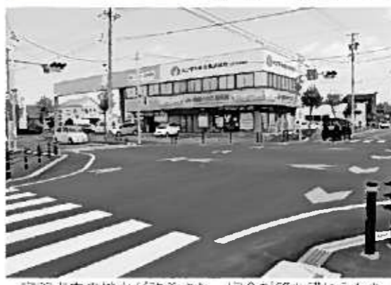
交差点内の排水が改善され、安全対策も講じられた
