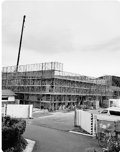
保育環境の充実が期待される。(建設中の桜保育所)
