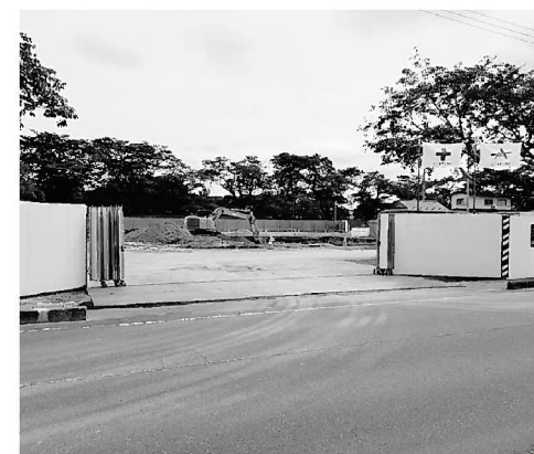
建設が始まった桜保育所（旧南桜公園）
