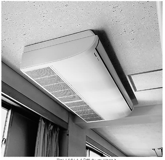
取り付けが進むエアコン
