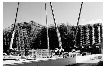
建設中のアイリスオーヤマ株式会社
