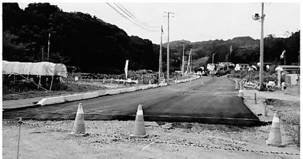
工事が進む新開五瀬線
