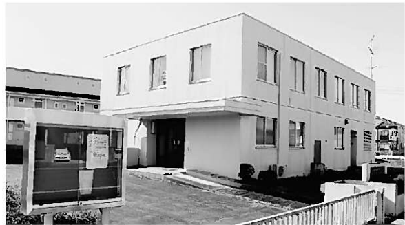
改修を行う旧検察庁大河原支部
