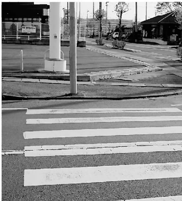
▲段差解消が図られる町道交差点
