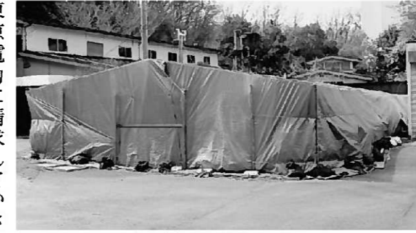
▲仮置きされている土砂
