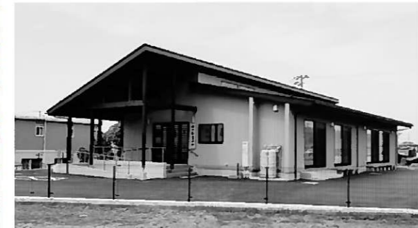
▲完成した稗田集会所
