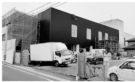
▲工事が行われている中央公民館
