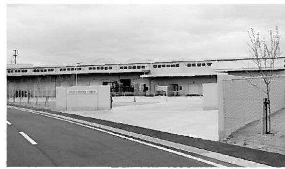
▲川根団地内のアイリスオーヤマ(株)大河原工場
