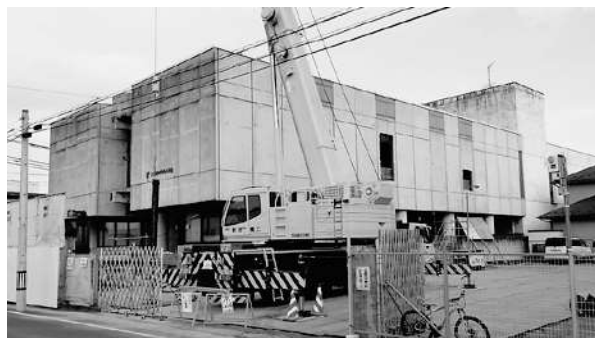
▲大規模改修中の中央公民館
