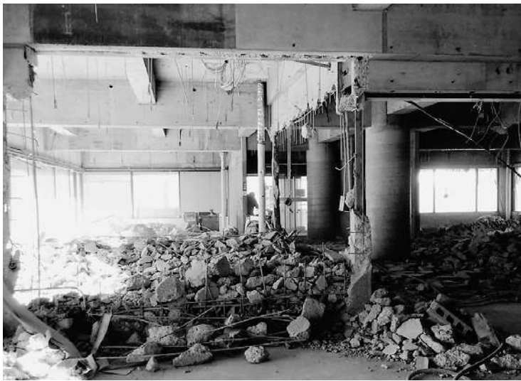
▲改修中の中央公民館内部
