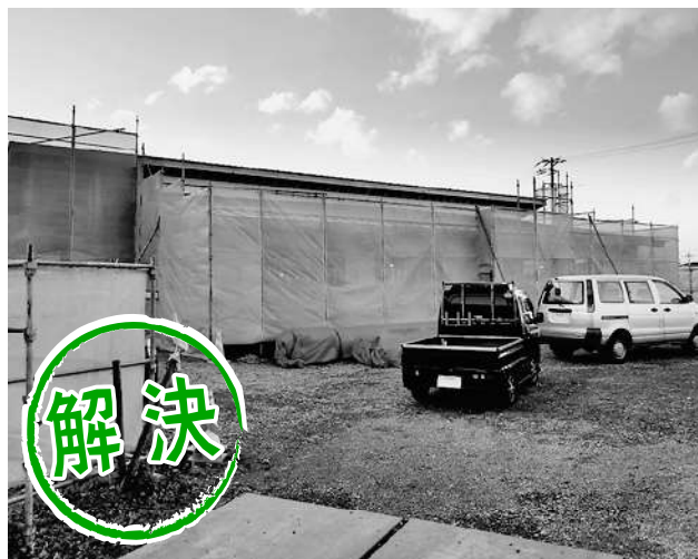
▲建設中の稗田前集会所
