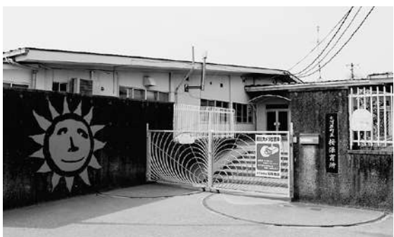
▲更新・改修が求められる桜保育所
