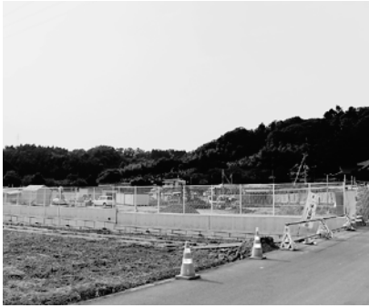
▲建設が進む金ヶ瀬カトリック保育園
