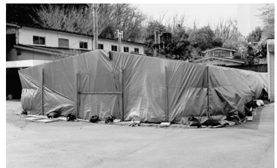
▲仮置きされている土砂
