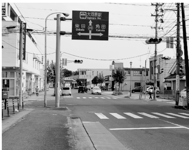
▲段差が解消された駅前交差点
