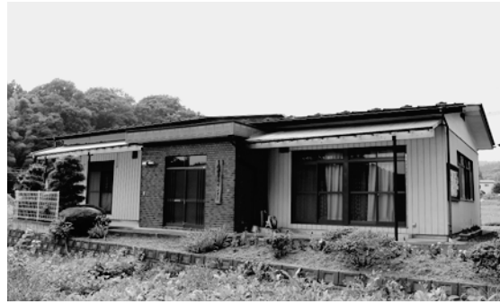
▲エアコン等の購入が予定されている新寺生活センター
