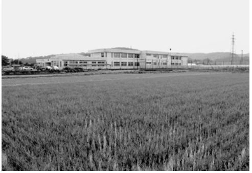
▲給食センター建設予定地(金中北隣り)
