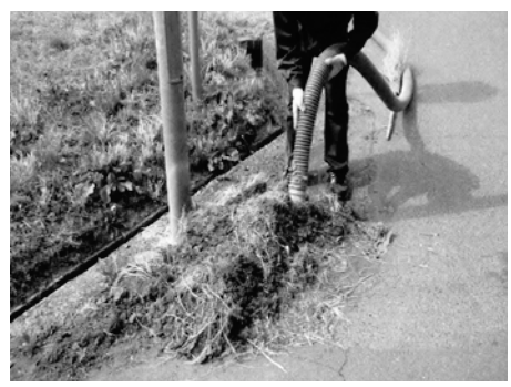
▲委託業者による土砂回収作業
