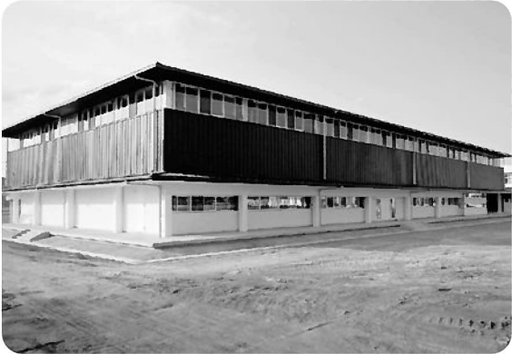
▲平成27年度に完成した金ヶ瀬中学校体育館
