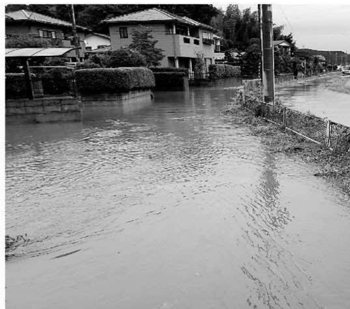
▲冠水した橋本地区
