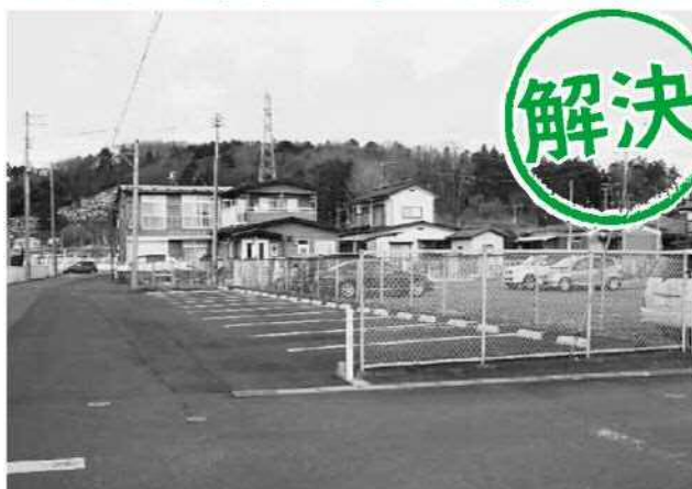
▲駐車場に整備された金小裏防火水槽
