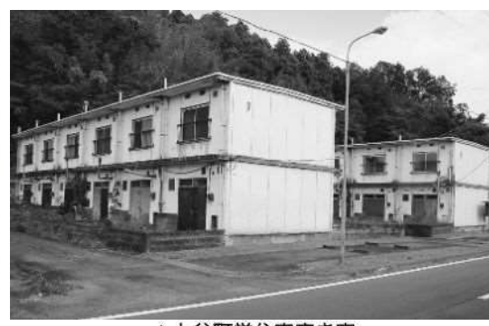
▲上谷町営住宅空き家
