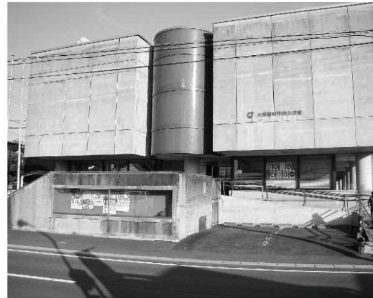
▲老朽化対策の必要な中央公民館
