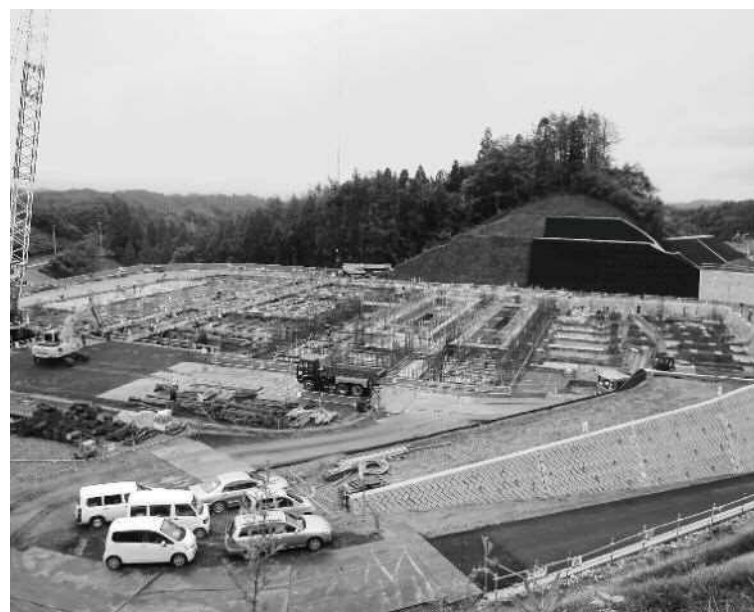
▲建設中の(仮称)仙南クリーンセンター
