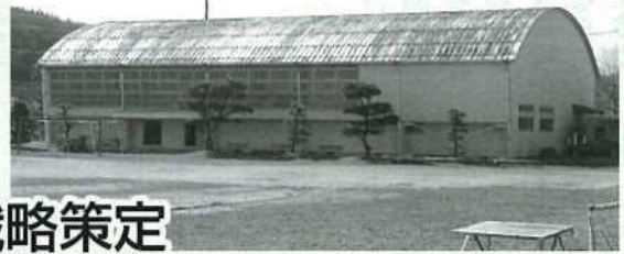
▲老朽化により建て替えとなる金ヶ瀬中学校体育館
