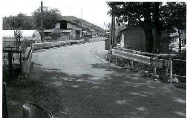
▲道幅が狭く危険が多い上大谷地区
