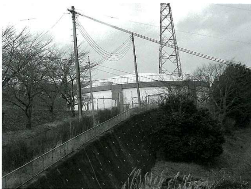
▲上水道配水池(大高山)
