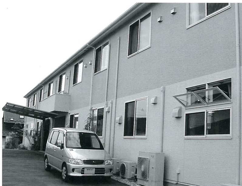
▲サービス付高齢者向け住宅（角田市）
