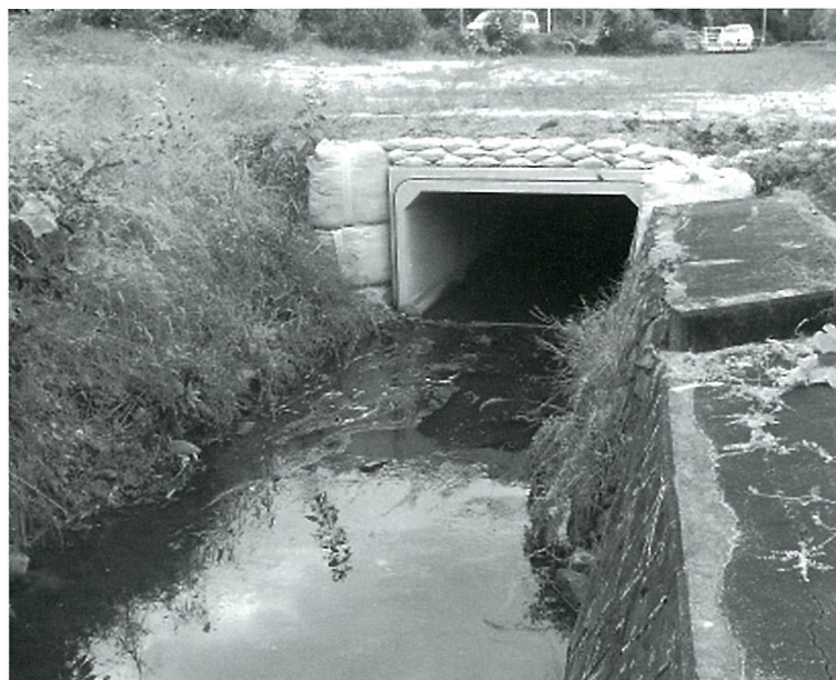
▲鷺沼排水路(県道上流側)
