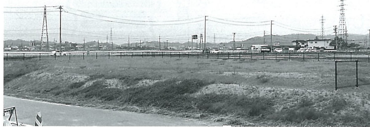
▲西地区交流センター造成工事
