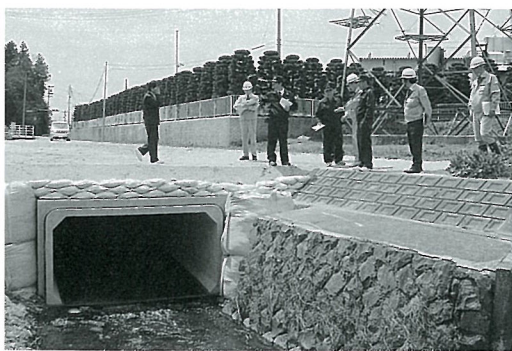
▲館山下県道とJR間の雨水幹線整備
