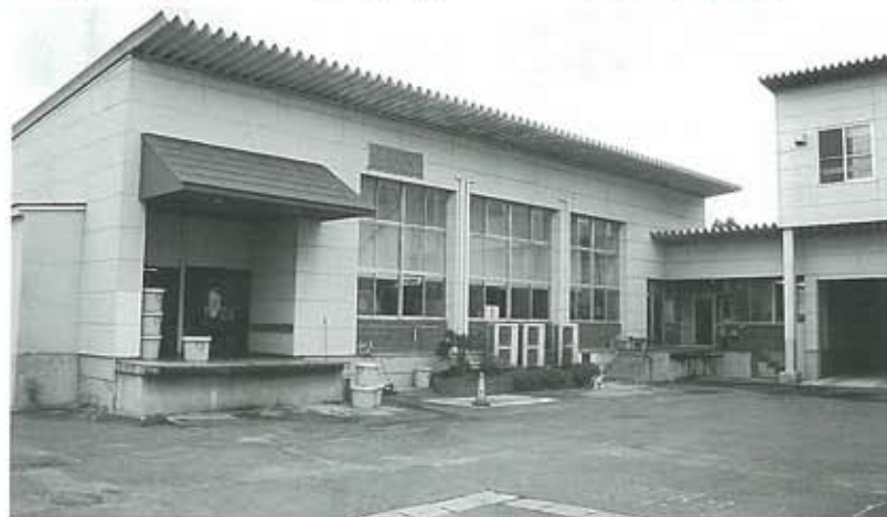
▲老朽化が進む学校給食センター
