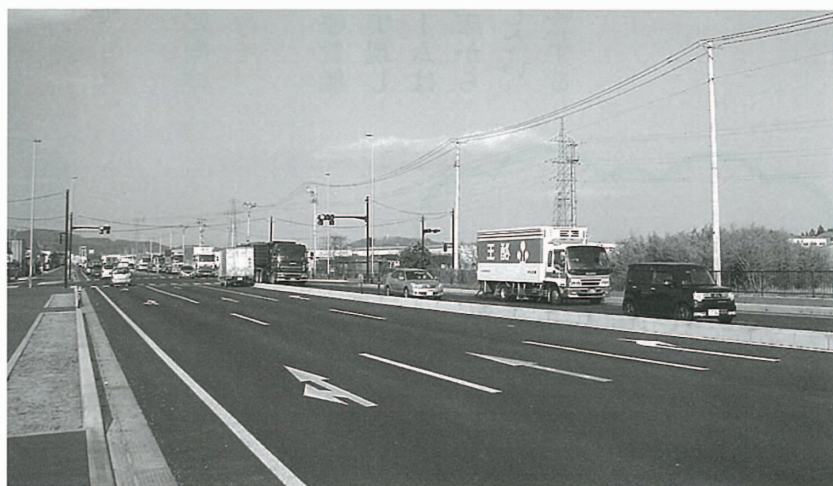
▲国道4号金ヶ瀬地区
