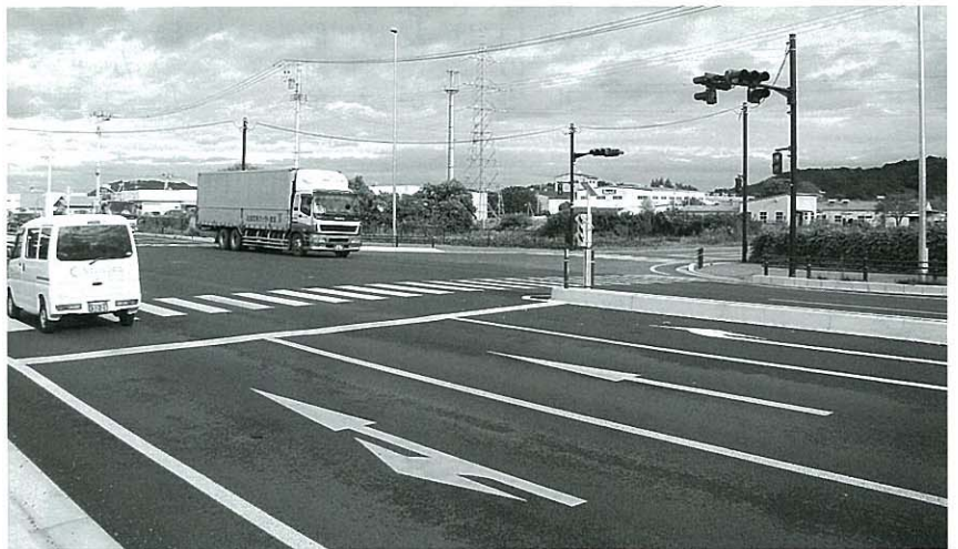
▲国道4号金ヶ瀬地区
