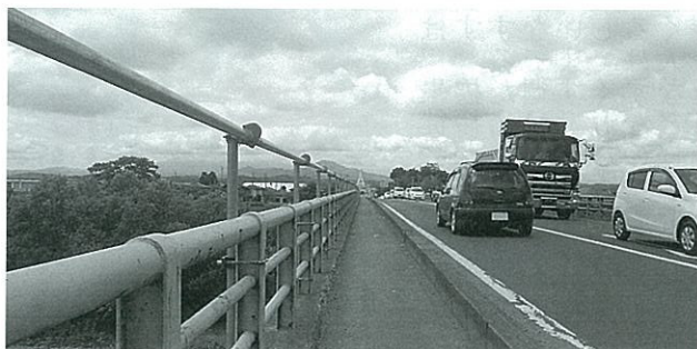
▲大河原大橋歩道
