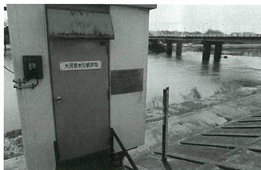
▲白石川左岸大河原水位観測局
