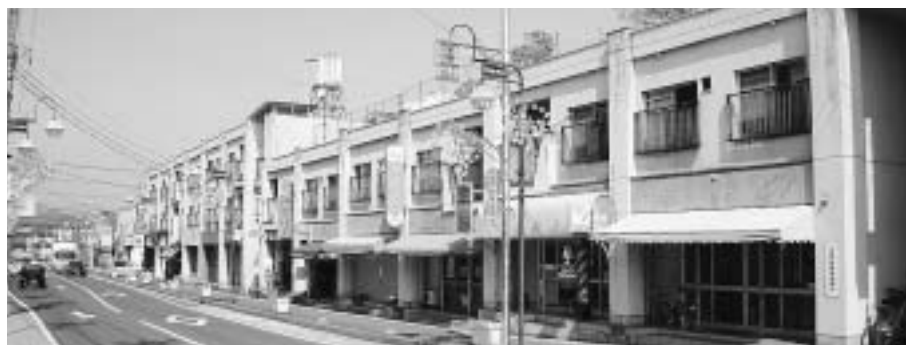
▲耐震化工事をおこなう町営栄町住宅・店舗
