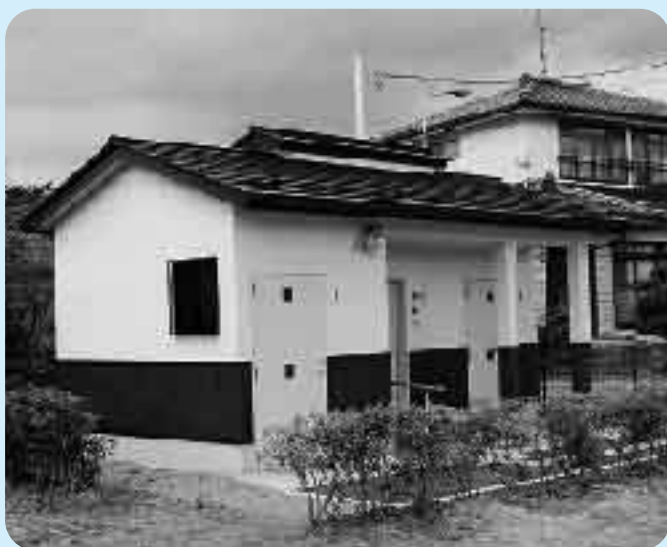
▲保科公園内に設置した桜堤トイレ
