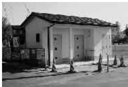
▲大中グラウンド隣の公園に公衆トイレを設置
