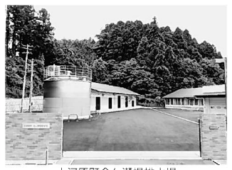
大河原町金ヶ瀬揚排水場
