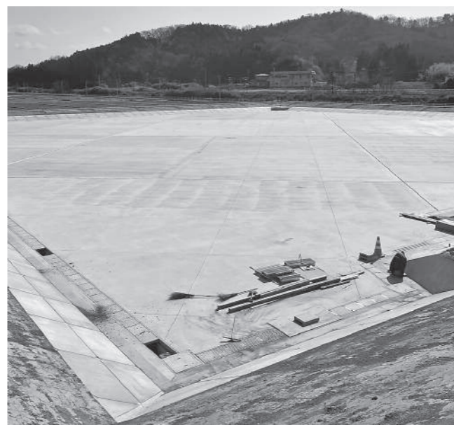
現在工事進行中の調整池
