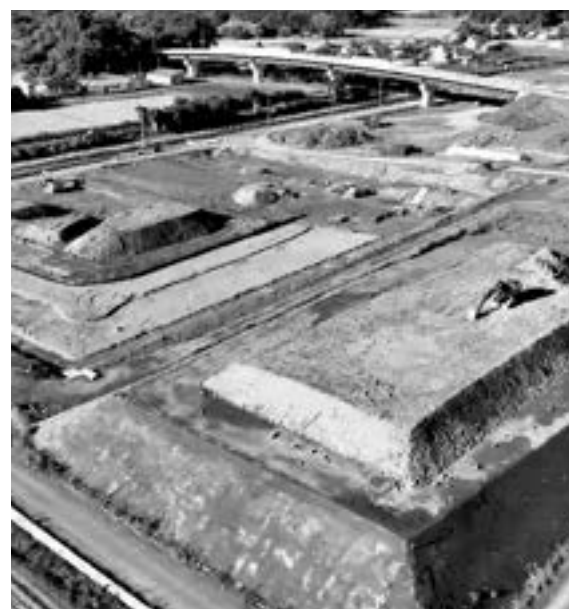
令和10年4月オープンに向けて工事しているが
