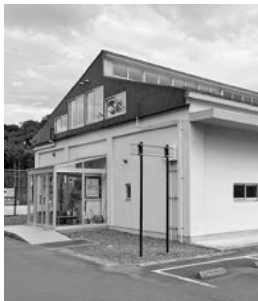
まずは、東部屋内運動場へのエアコン設置から
