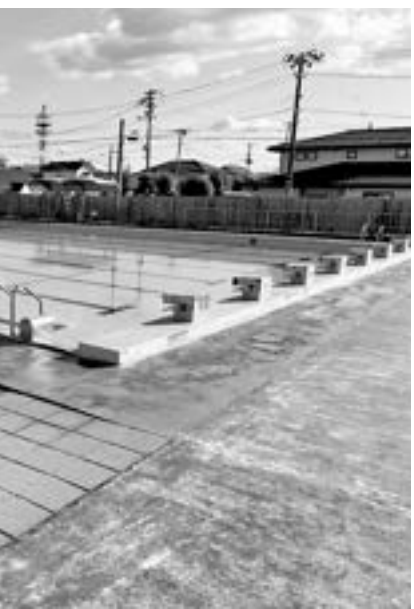
老朽化が進むプール
