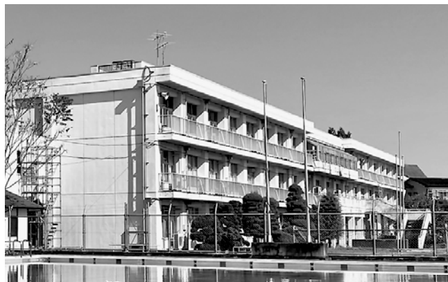
南小学校1号校舎の外壁・屋上の防水ほか 改修工事がはじまります。
