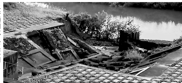
上谷樋門応急工事前
