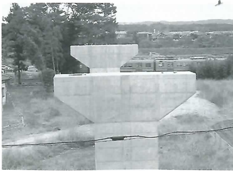
▲大谷跨線橋進捗状況
