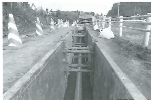
▲上谷地区下水道工事
