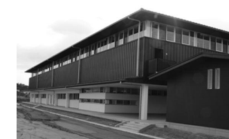
▲新しい金ヶ瀬中学校体育館。
