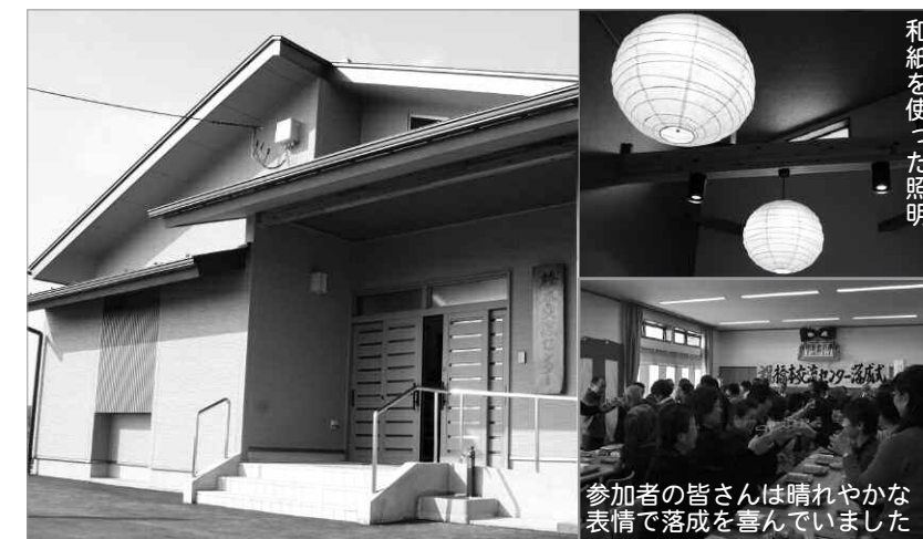
▲災害時に必要な物資の保管・備蓄や炊き出しなどを行える第一次避難場所としても使用されます。
